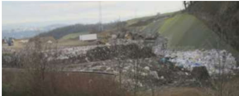
décharge du Melay à St Romain en Gal (pas de valo)
