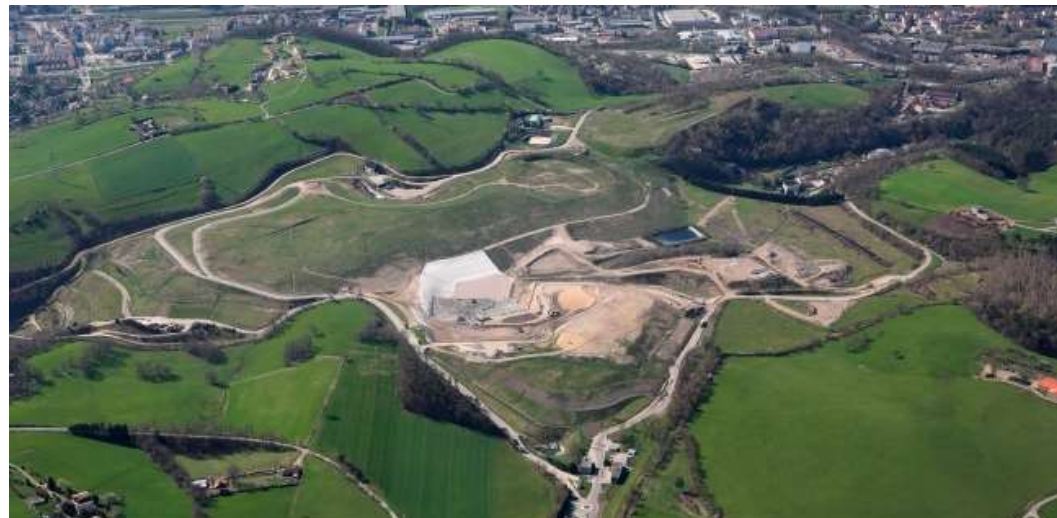
décharge de Borde-Matin à Roche-la-Molière 23 000 MWH/an d'électricité vendus
