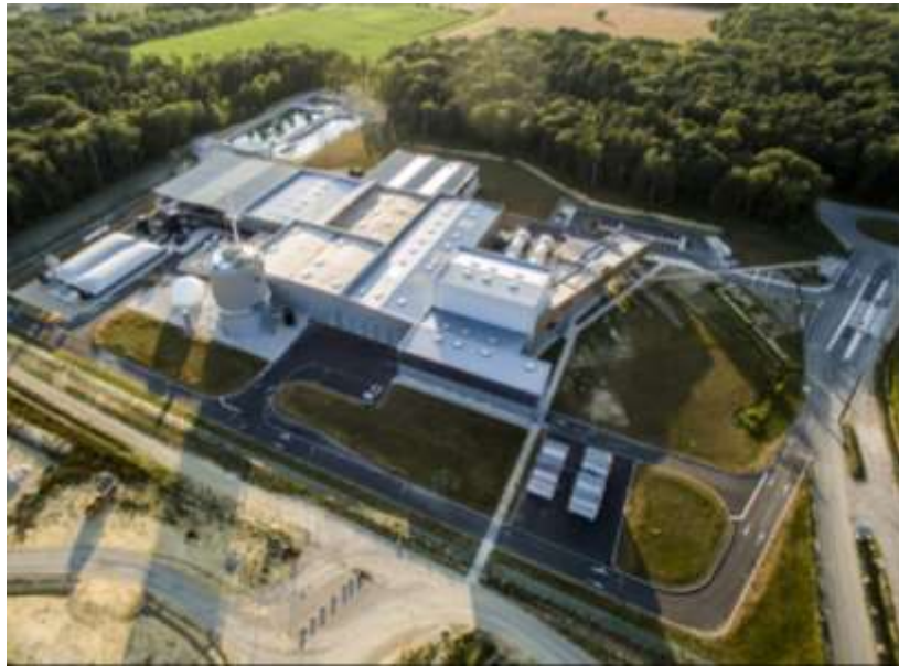
Ovade, usine de cogénération du Syndicat ORGANOM à Viriat 320 000 habitants
